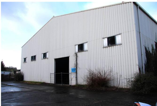
*Dans cette zone la façade est constituée par un bardage métallique en assez bon état. Il existe un soubassement en maçonnerie. 2019.03.04 (66) et (9)*
