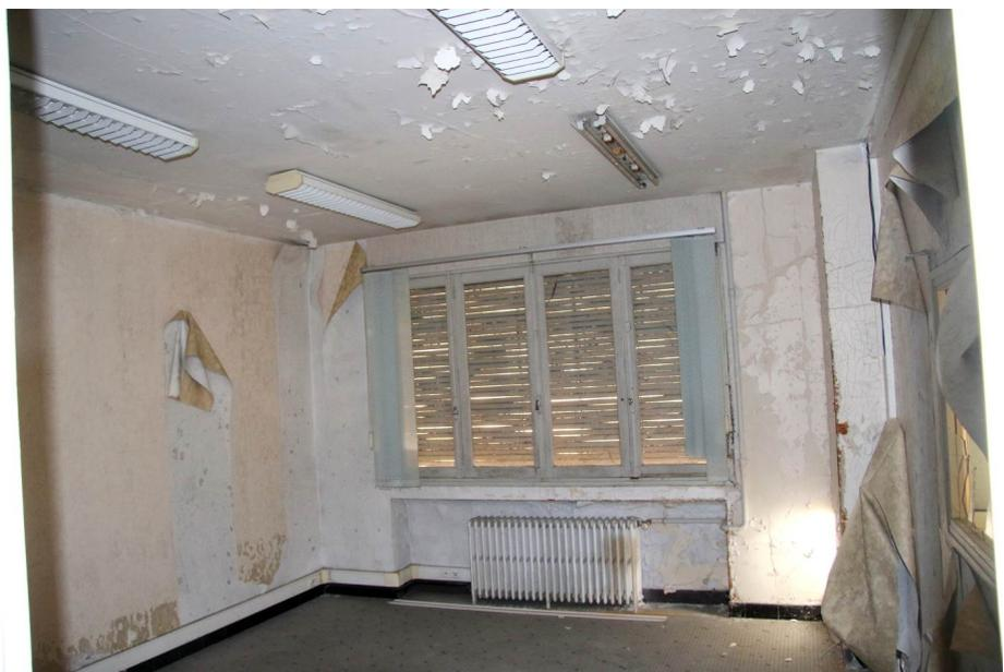
**Dans le bâtiment D16, les revêtements sont généralement en très mauvais état. Les appareils d'éclairage et radiateurs subsistent. 2019.03.04 (37) et (29)**
