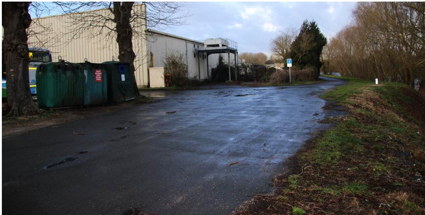
*La voie qui longe le Cher et conduit entre autres à la station d'épuration est en assez bon état le long du site. Le reste de la voirie est en assez mauvais état. Elle présente des zones de rétention d'eau. Le site n'est pas clôturé le long de la limite de propriété. Un poste de détente gaz est situé à l'angle nord-est du site. 2019.03.04 (1)*
