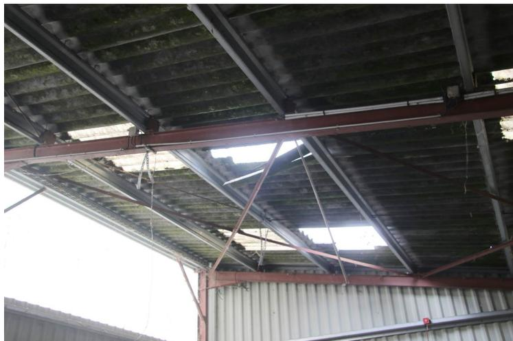
*Petit bâtiment à ossature métallique couvert en amiante ciment en mauvais état. 2019.03.04 (89)*
